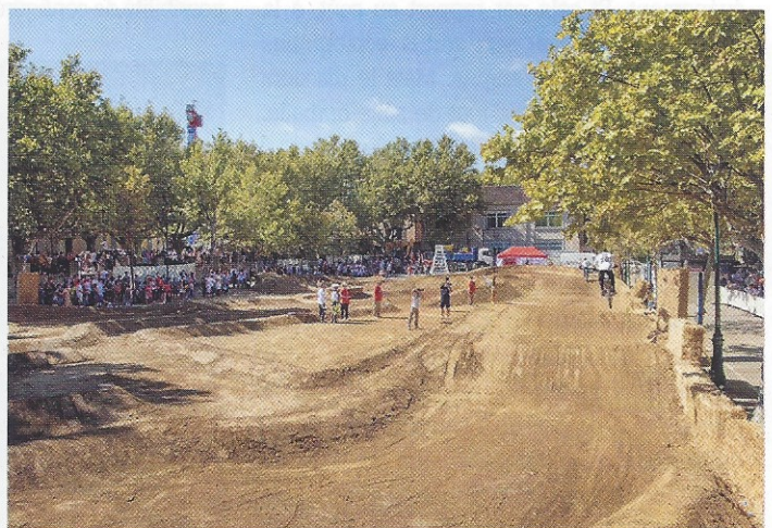
TRACK - GTP et Espace Services auront déposé 1 700 tonnes de terre pour la création du circuit.
